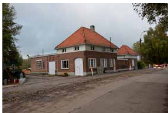
Figuur 54. Pompstation Watering van de Valleien der Zuidlede (Erfpunt 2020).
