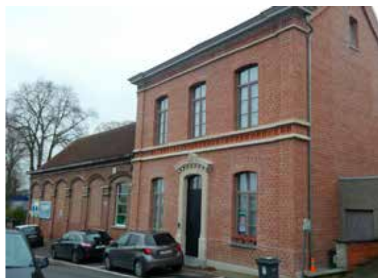
Figuur 76. Gemeenteschool op de Roomakker in Tielrode, waarvan de ramen van de benedenverdieping voorbeeldig zijn hersteld naar oorspronkelijk model. Een vergelijkbare portiek was terug te vinden in het inmiddels verdwenen schoolmeestershuis van Vrasene.
